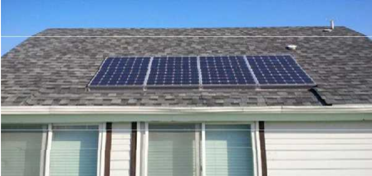
Figure II-45 Photo du bâtiment expérimental [46]
