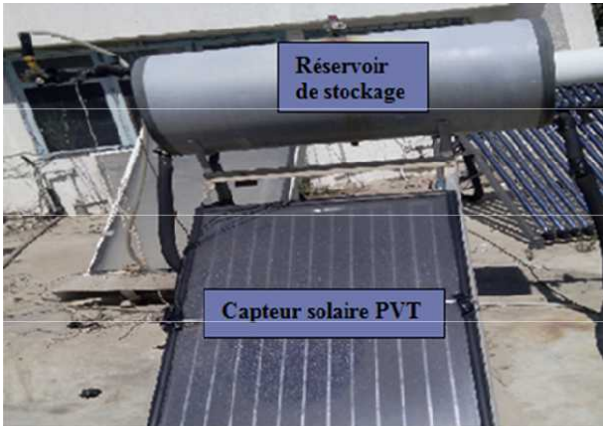
Figure II-38 :Capteur PVT avec ballon de stockage [40]
