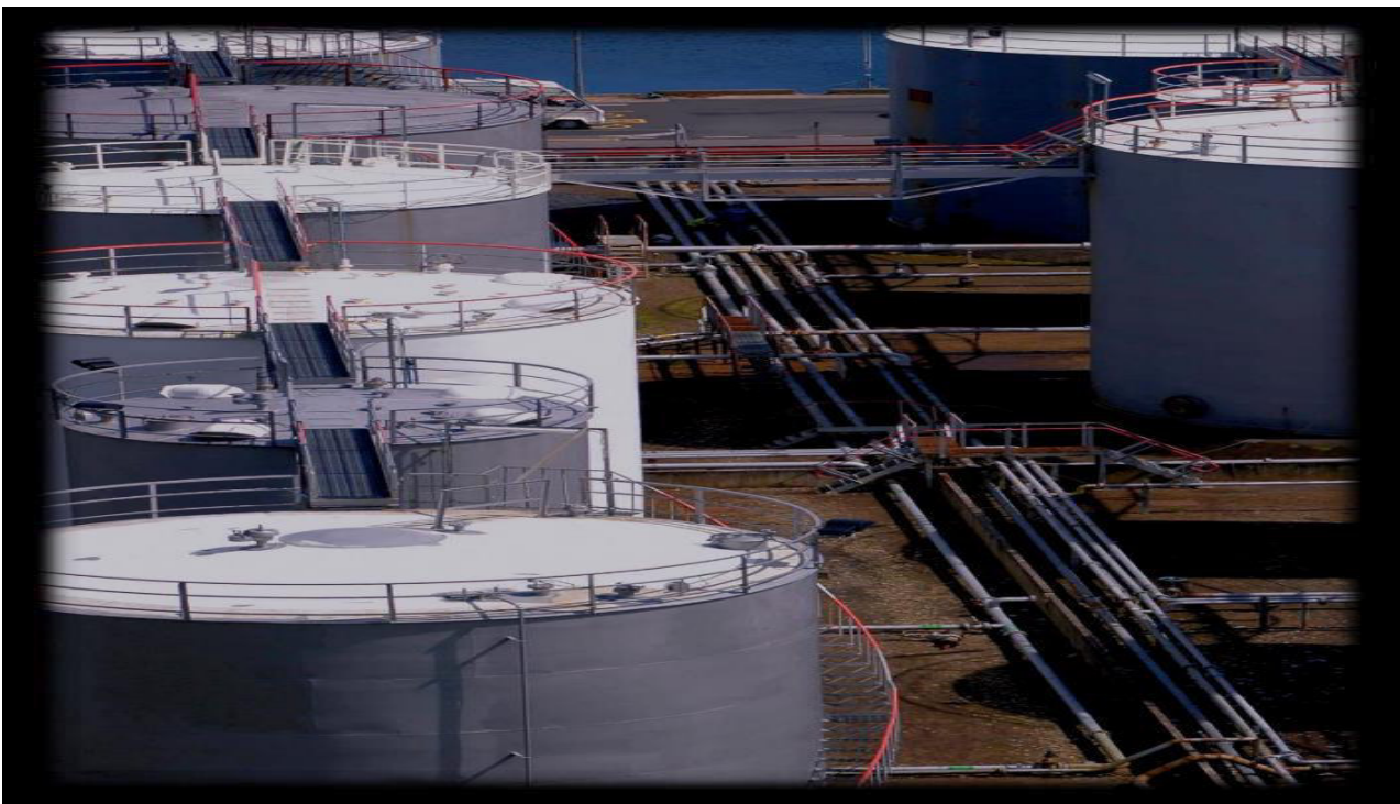
Figure 42.2 : Bac De Stockage Et Réseau Pipe
