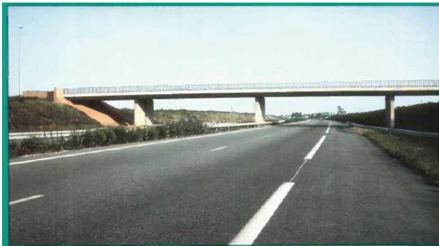
Figure (I-4) : photo représente un pont-dalle.
