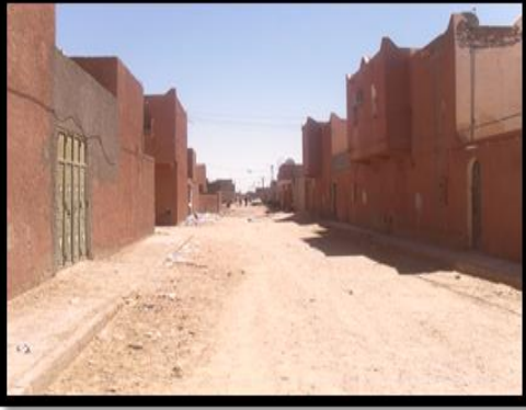
الصورة (37): طريق رديئ
