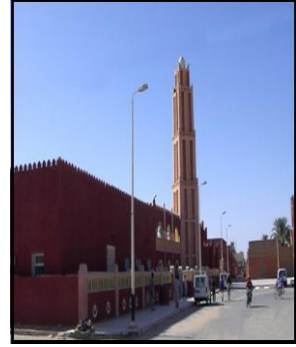
الصورة رقم (7) : تجهيز ديني
