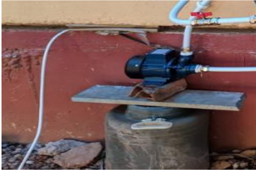
Figure II-10 « Installation du moto-pompe ».
