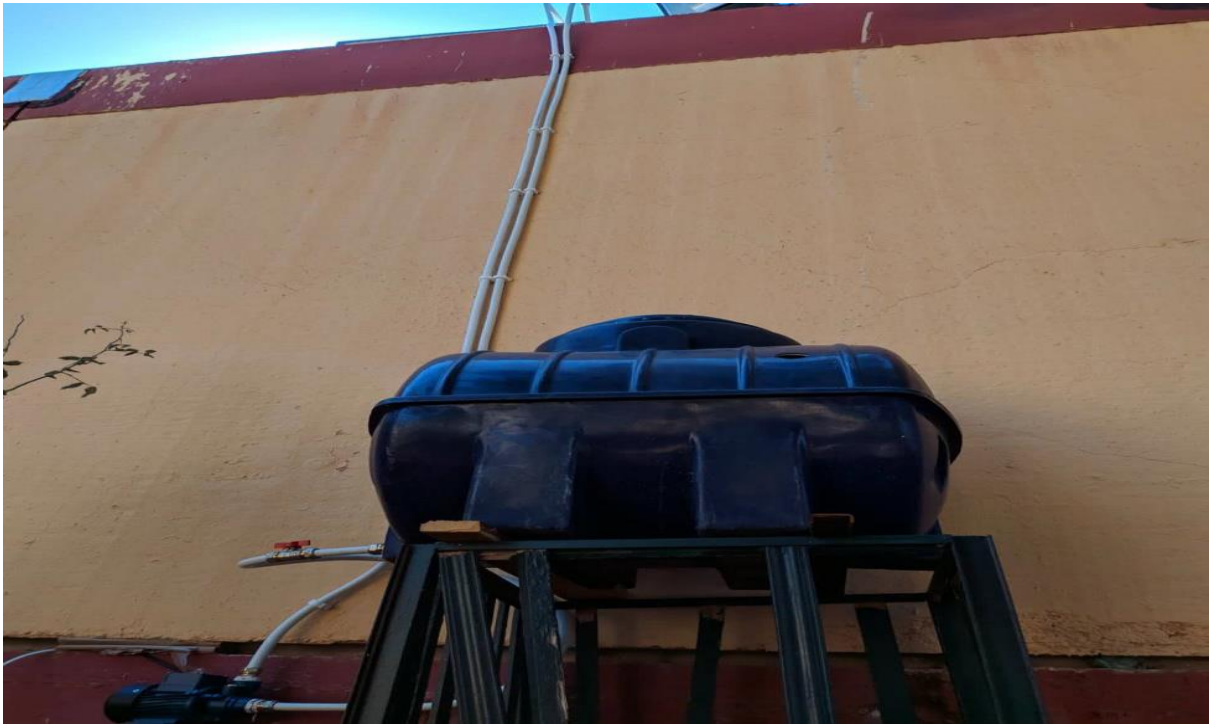
Figure II-9 « photo de l'installation de la canalisation ».
