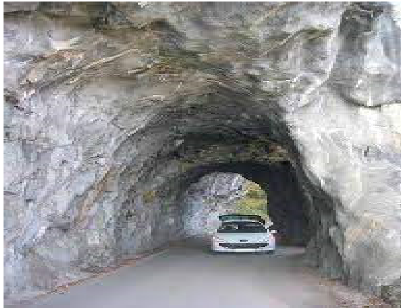
Figure IV.22 : tunnel non revêtu.
