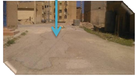
صورة رقم ( 06 ) المنفذ الجنوبي للحي
