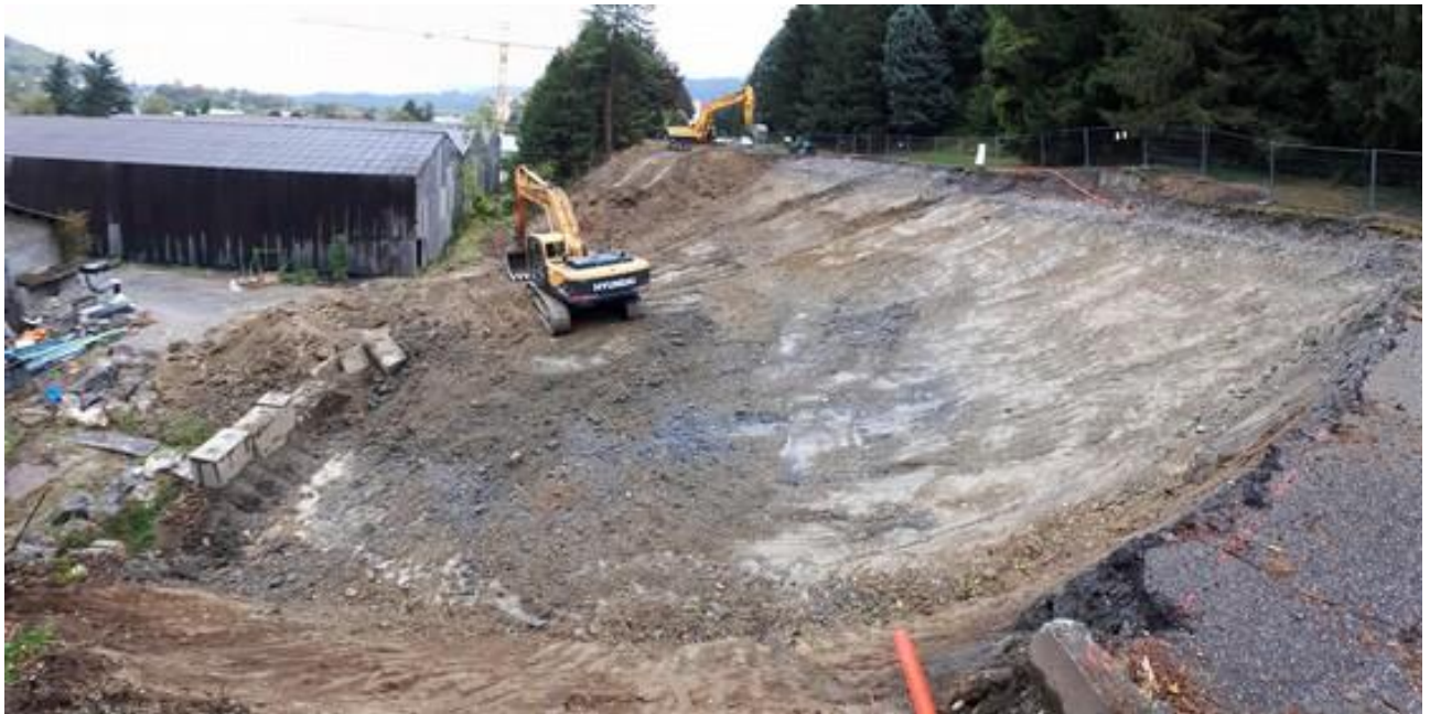
Figure I.16 : Travaux de terrassement.
