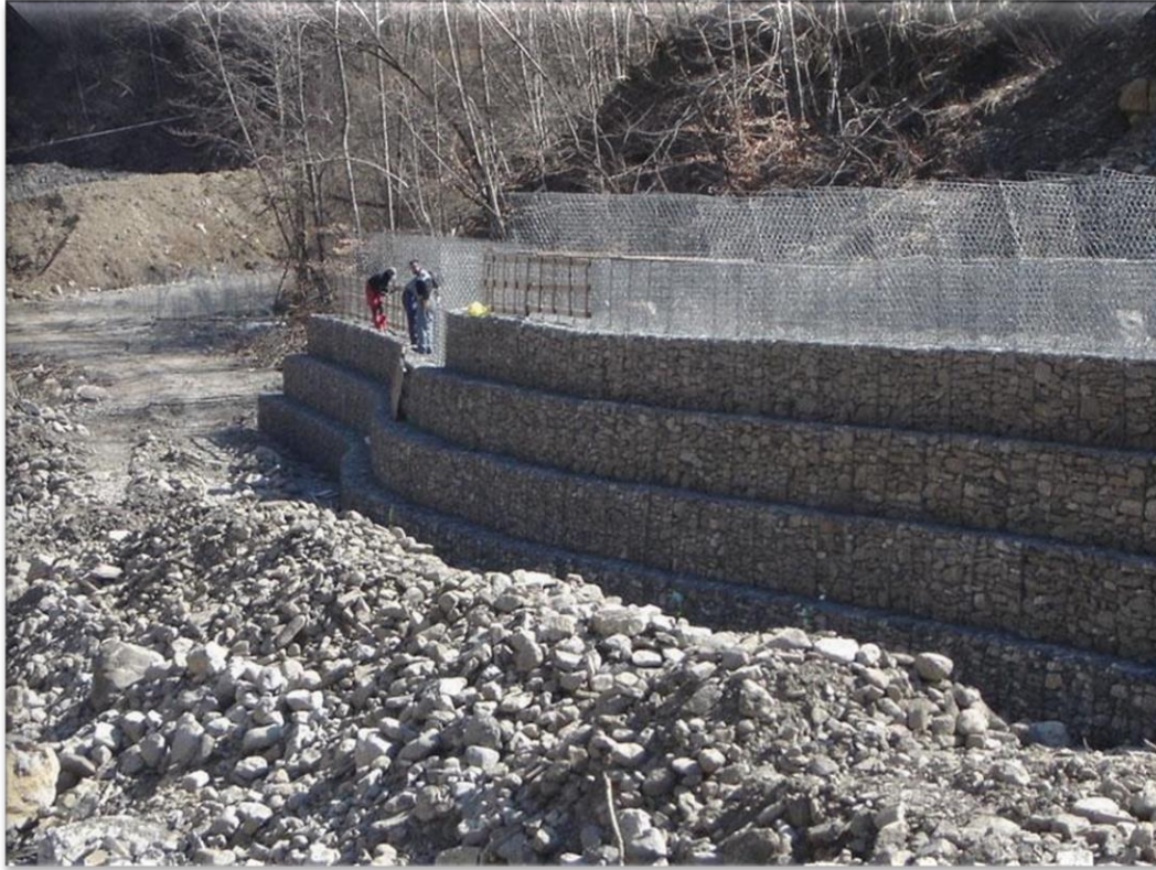
Figure I.19 : Réalisation d'un mur en gabion. [16]
