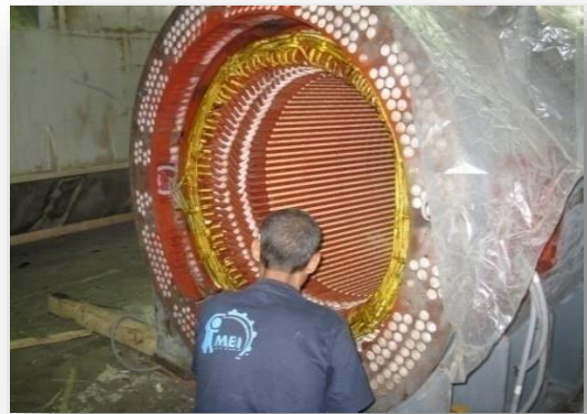
Figure III.8 réparation de rotor
