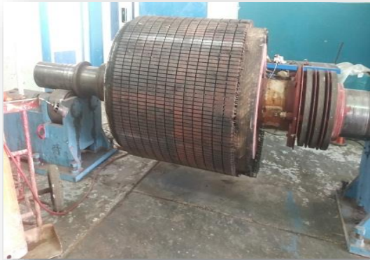
Figure III.7 réparation de stator
