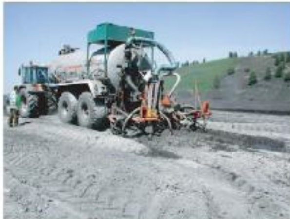
(c) mélangeur-épandeur, avec citerne attelée sur tracteur, équipé d'un distributeur de service
