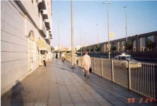
الصورة (01-02): السياج الحامي للمشاة عند حافة الرصيف
