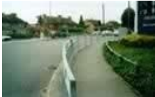
الصورة (01-02): السياج الحامي للمشاة عند حافة الرصيف
