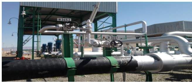
Figure (2.15) : Les soupapes de décharge.
