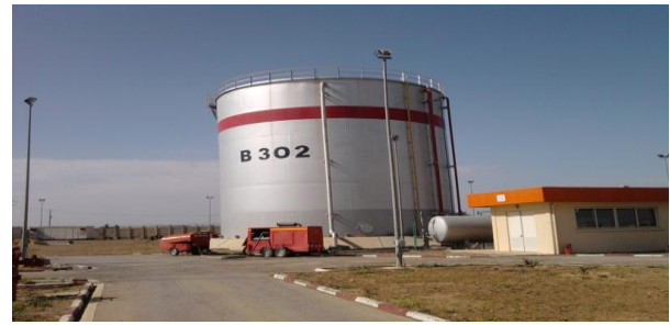
Figure (2.11) : Bac B 302 à toit fixe.
