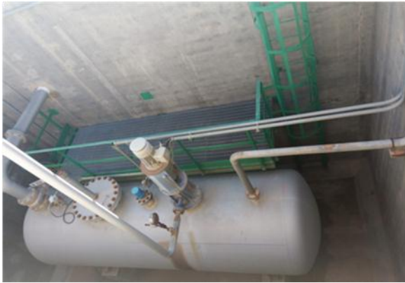
Figure (2.3) : Ballon de purge avec la pompe P305
