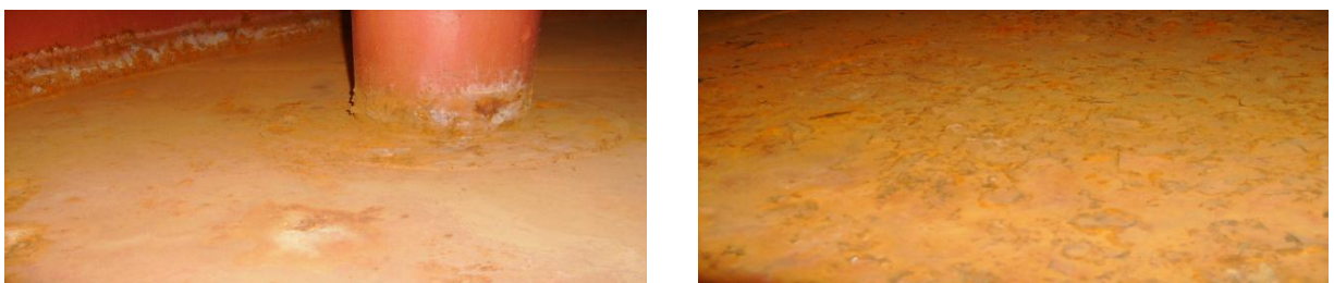
Figure (3.8) : Corrosion au niveau de caisson N°37 bac 3A1.
