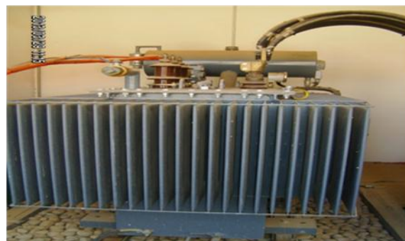
Figure (2.8) : Transformateur basse tension 19
