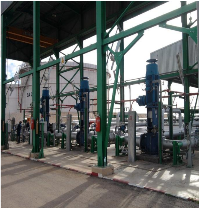
Figure (2.2) : électropompes boosters
