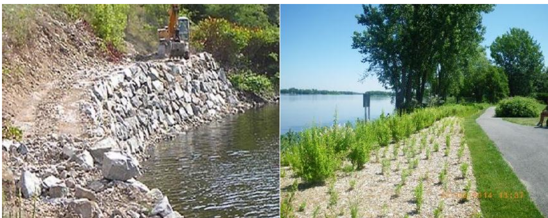
Figure VI.2 : aménagement avec maçonnerie à gauche et à droite en enrochement liaisonnée
