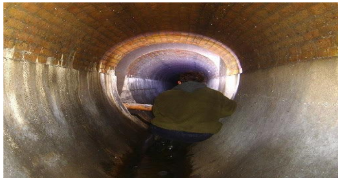
Figure IV.5 : photo d'une section ovoïde
