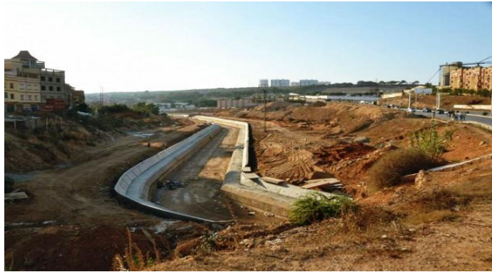
Figure IV.56 Exemples de réalisation D'un canal trapézoïdale
