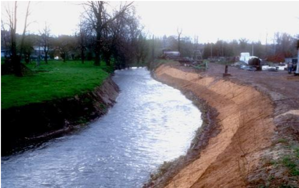
Figure IV.4 : Exemples de réalisation de géotextile
