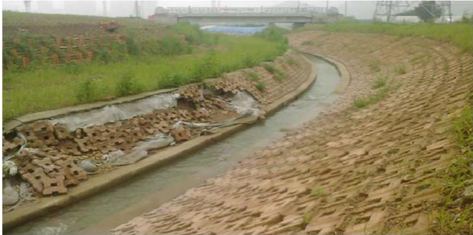
Figure IV.3: vue en plan des blocs de béton
