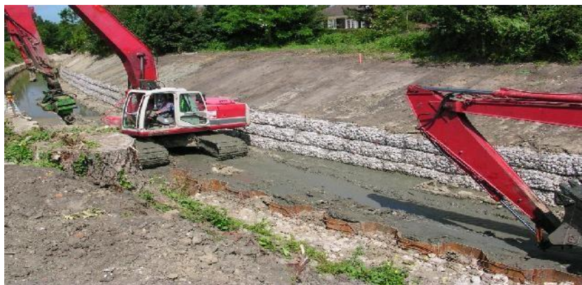
Figure VI.1 : Exemples de réalisation d'un mur en gabion
