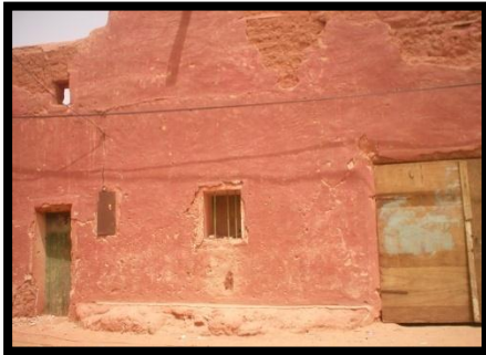
الصورة رقم(28) : واجهة معمارية قديمة
