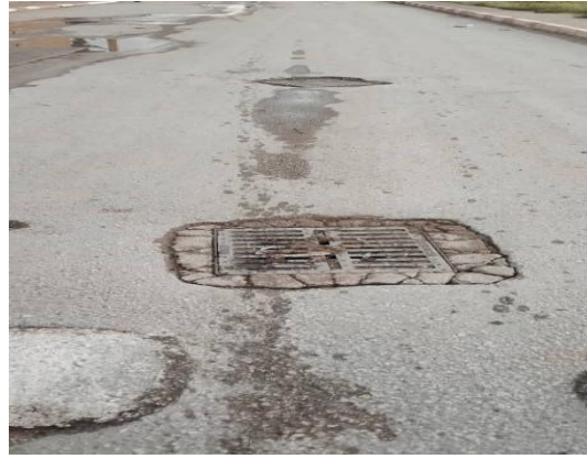
الصورة 10: ضعف تهيئة شبكة تصريف المياه السطحية
