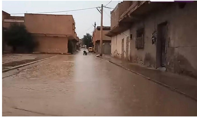
الصورة 02: تجمع مياه الأمطار بأحد شوارع حي صديقي النوري نتيجة ضعف شبكة التصريف السطح
