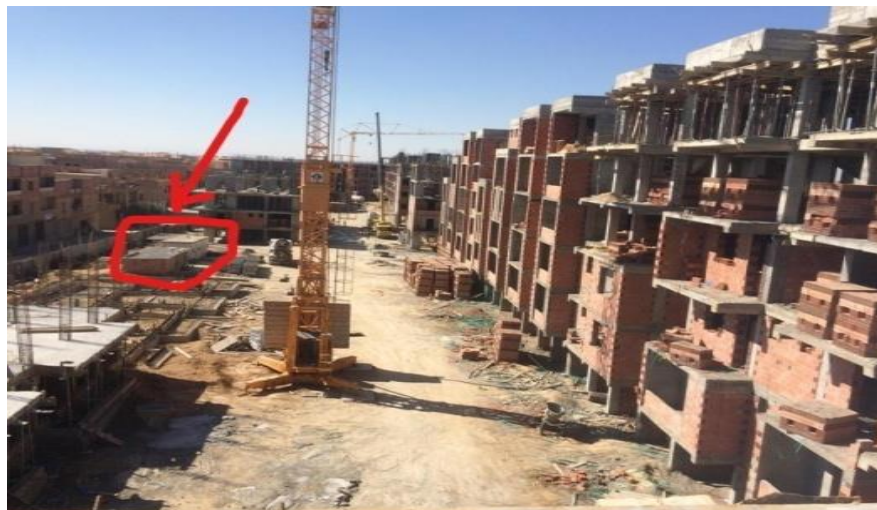
Figure III-9- Installation de la cité ouvrière
