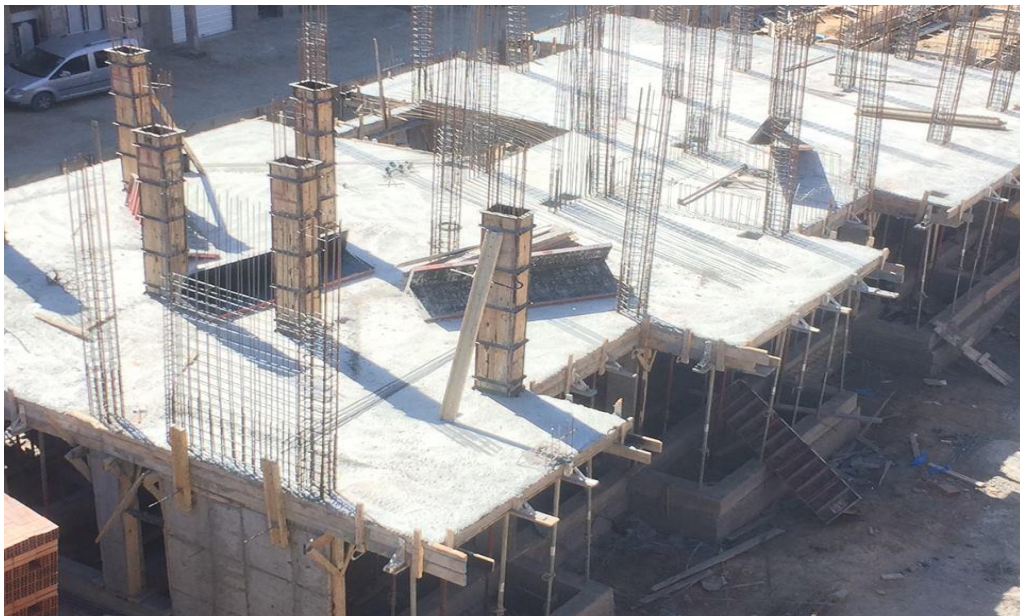
Figure III-12- Coffrages en bois des poteaux.
