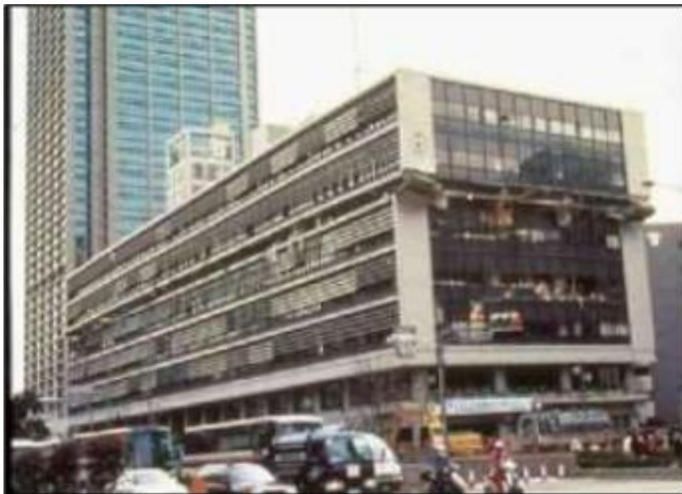
FIGURE 1.10 : Perte d'un étage de la mairie de Kobe (Séisme de Kobe (Japon) en 1995)
