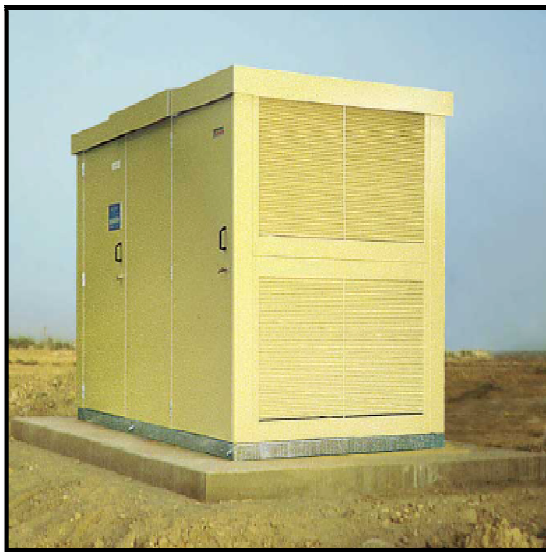
Figure (II.4.1) Poste préfabriqué
