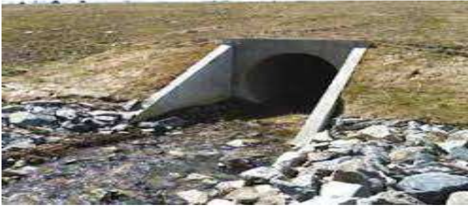
Figure I.5. Stabilisation des ponceaux [4].
