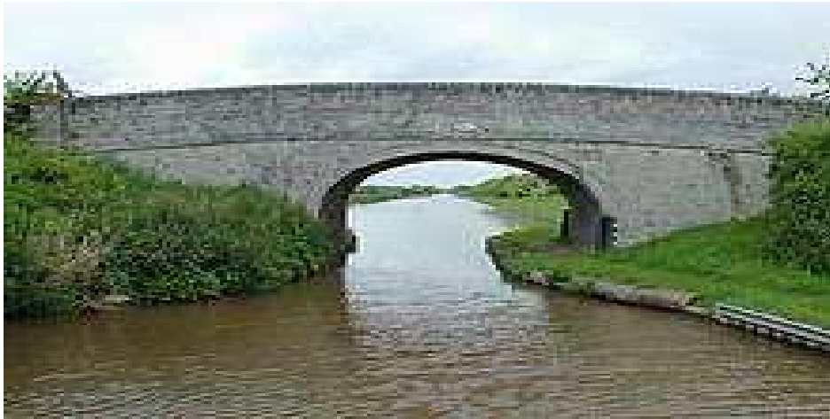
Figure I.7. Photo d'un pont [2].
