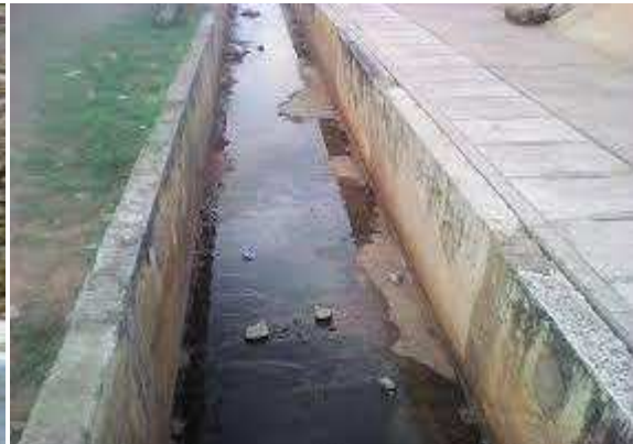
Figure I.3 caniveau a ciel ouvert
