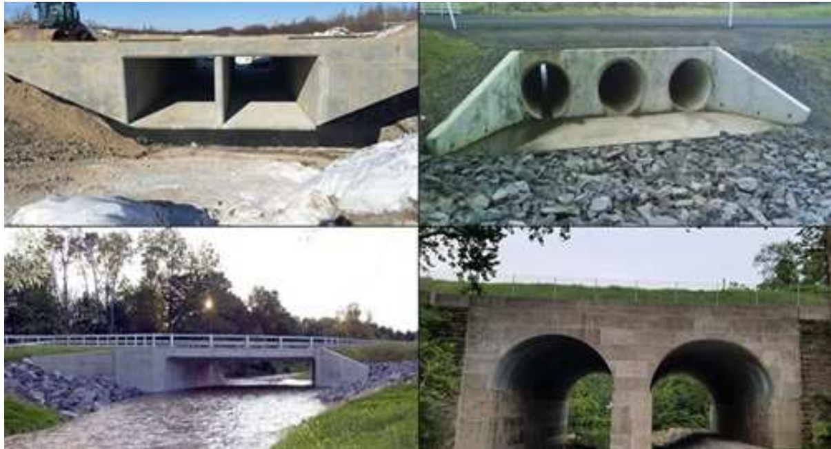
Figure I.4 les types de ponceaux [4].
