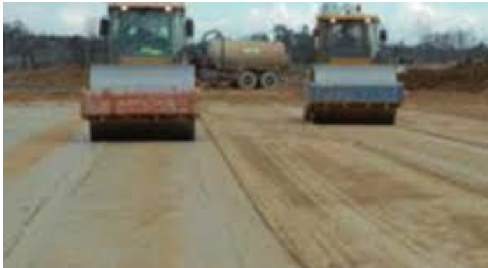
Figure I.22 : Le compactage du mélange de sol.
