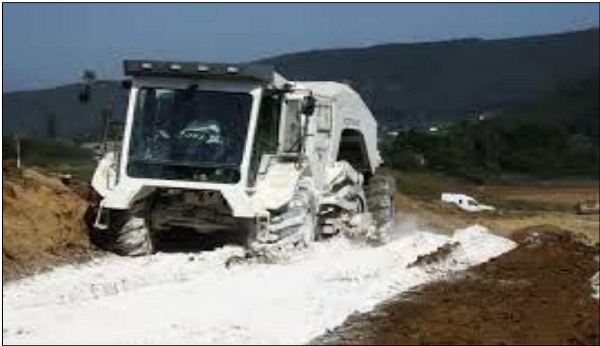
Figure I.17 : Traitement des sols à la chaux.
