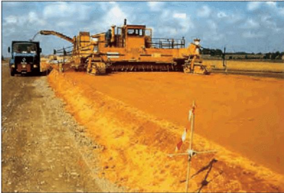
Figure I.20 : Préparation de la couche de forme.
