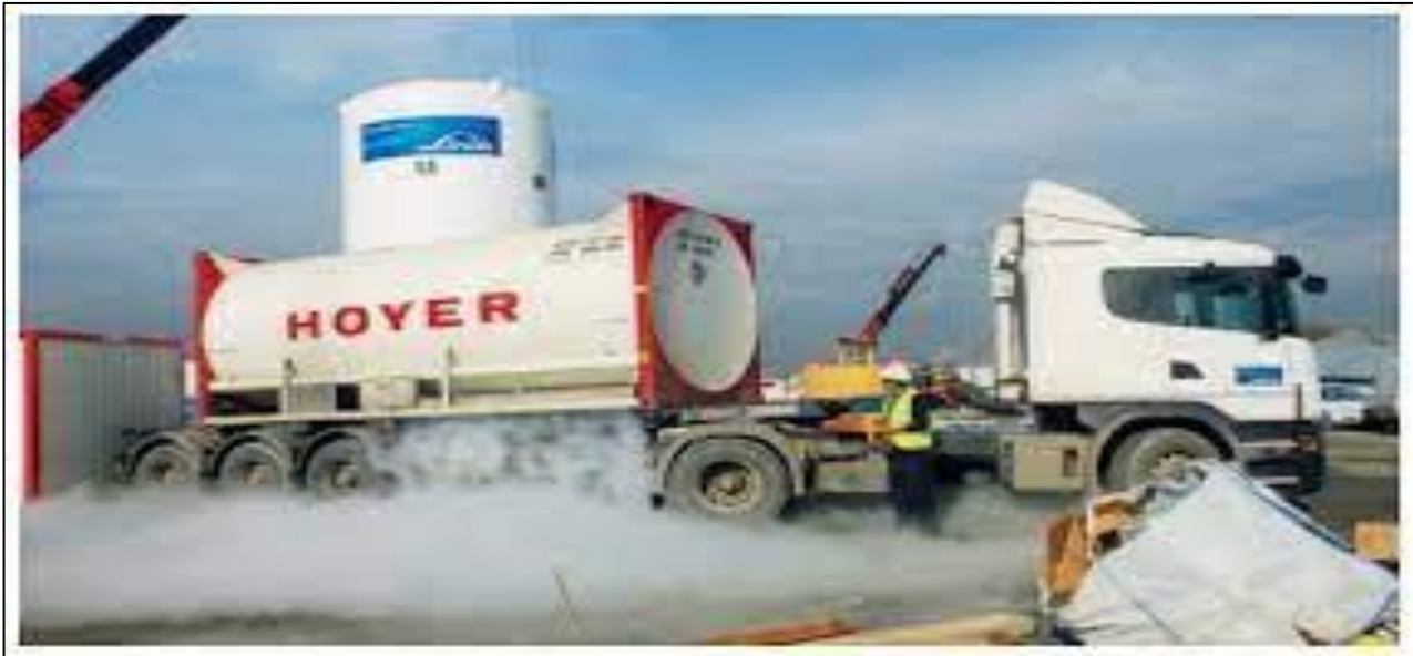
Figure I.15 : La congélation du sol sur chantier.
