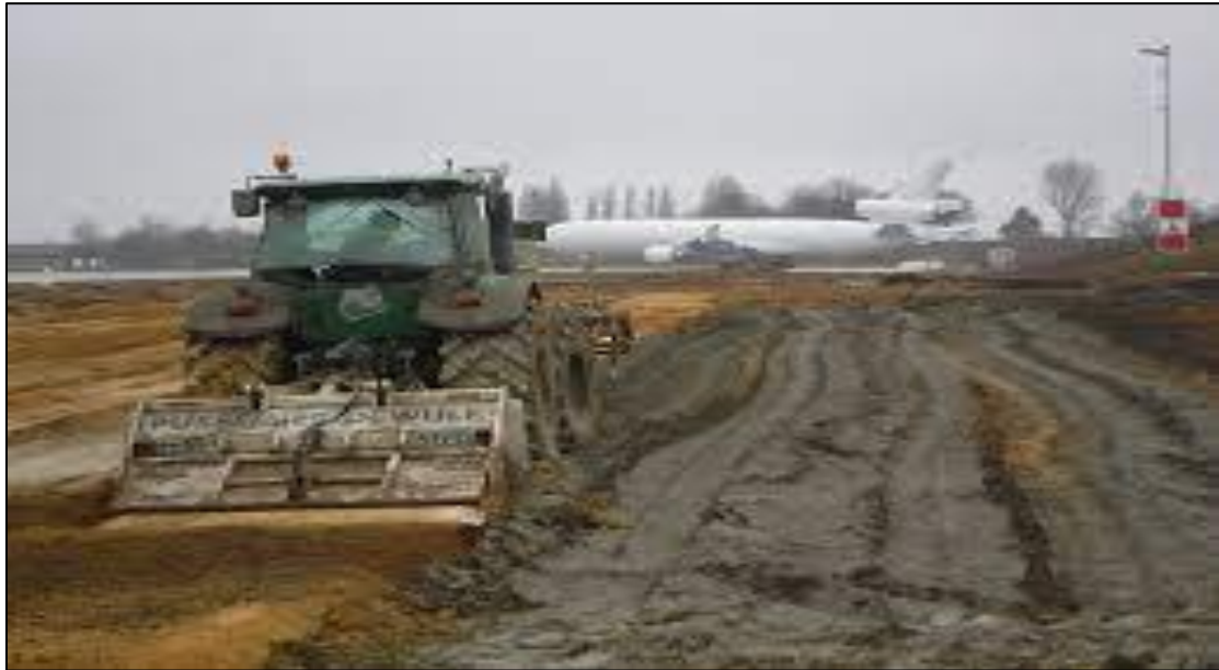
Figure I.18 : Traitement des sols au Ciment.
