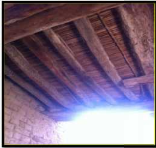
صورة رقم 46: إستعمال جذوع النخيل في التسقيف
