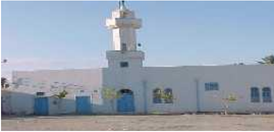
صورة 10 مسجد سيدي عمر
