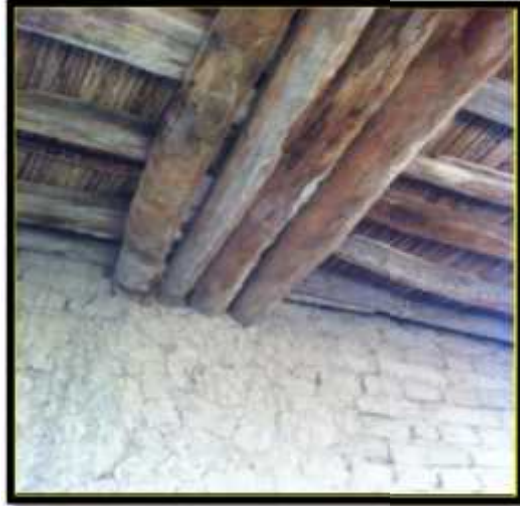
صورة رقم 54: حوامل من جذوع النخيل
