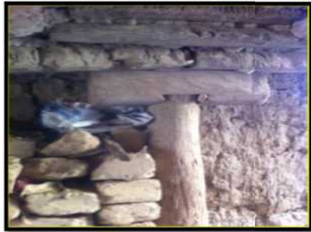
صورة رقم 51: أعمدة من أشجار الزيتون
