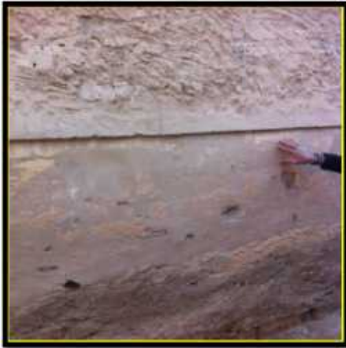
صورة رقم 53: التليس الخارجي بالجبس المحلي
