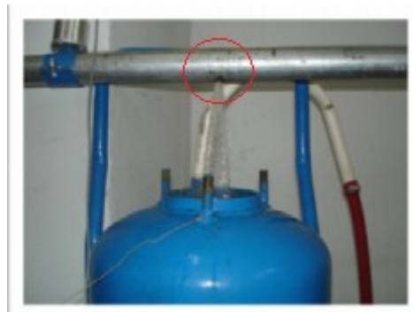
Figure (II.20) Perforation de la conduite, afin de stimuler une fuite
