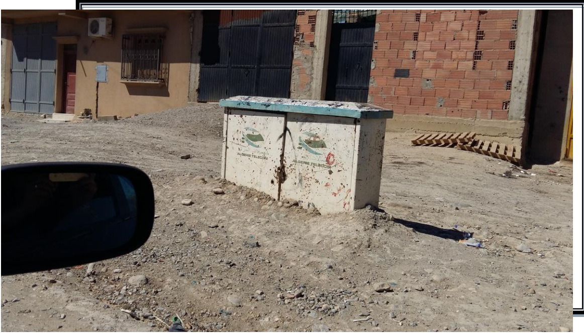
الصورة رقم : ( 21 ) شبكة الهاتف بحي بوخميسة
