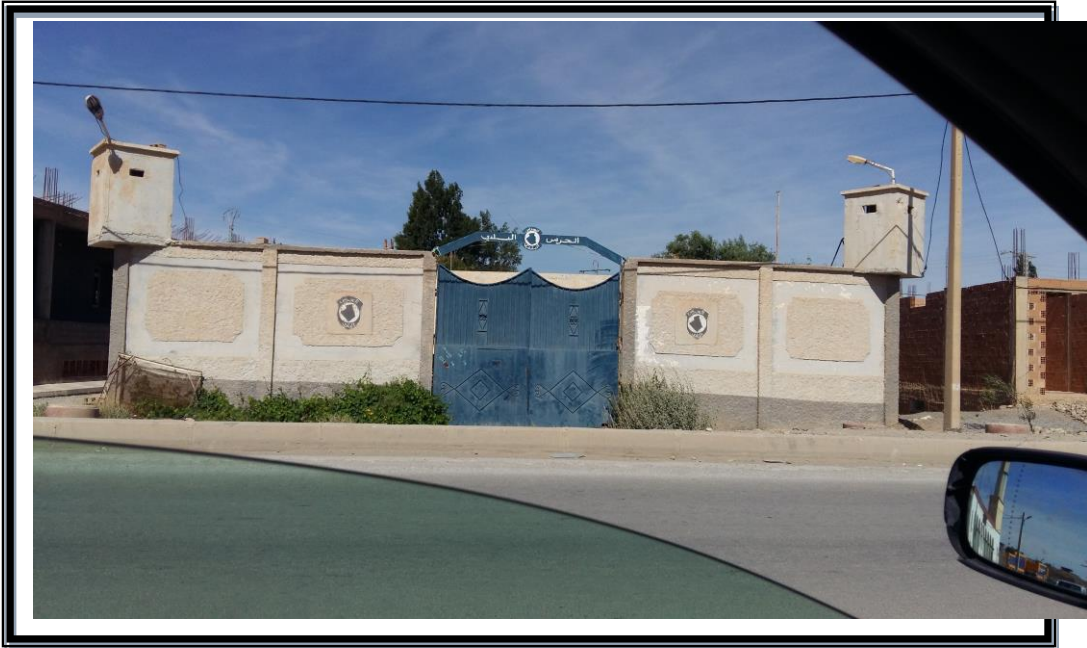
الصورة رقم : ( 14 ) مفرزة الحرس البلدي بحي بوخميسة
