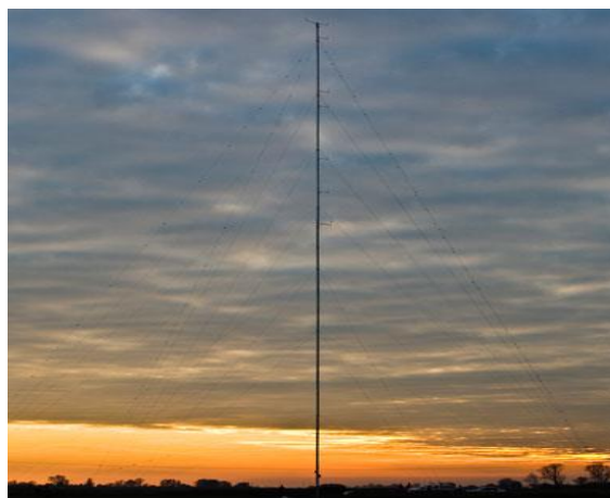
Figure III-9 : Pylône de mesure [43]
