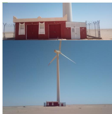
Figure IV-9 : L'éolienne et le kiosque adjacent
