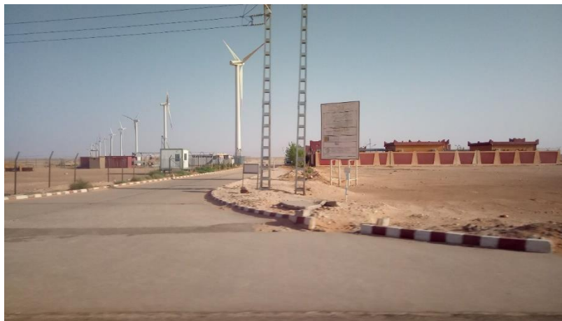
FigureIV-1 : Ferme éolienne de Kabertène
