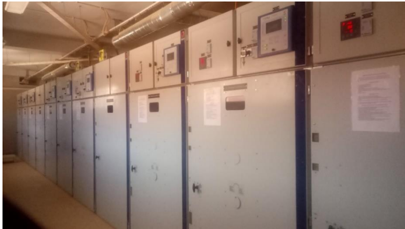
Figure IV-5 : Le poste de moyenne tension 30kV
