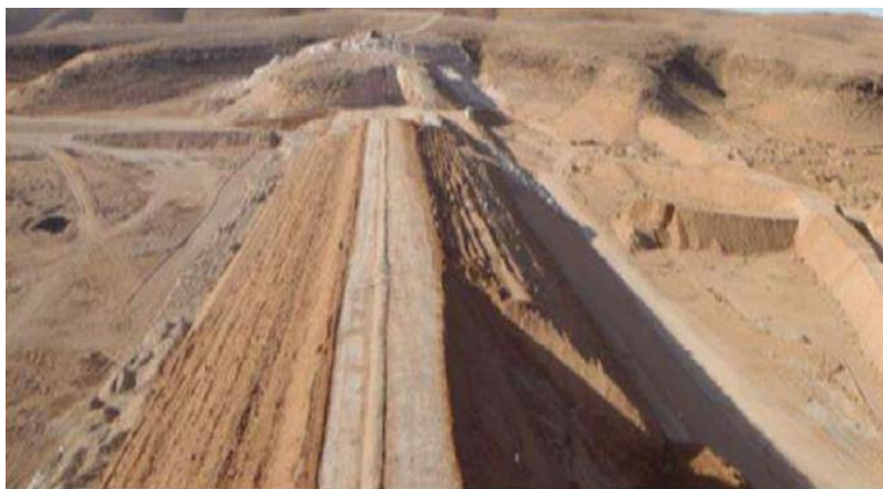
Fig. I.1 Barrage en terre El-Haimeur dans la wilaya de Ghardaïa en Algérie [1]
