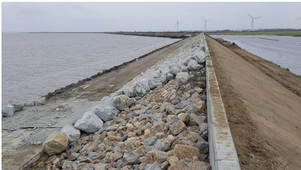
Fig. I.4 Digue en terre avec masque rocheux [4]
