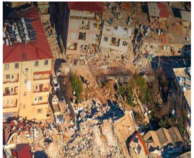
Figure I.7: Exemple de dommages [4].
