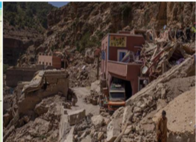
Figure I.9. Exemple de dommages [5].
