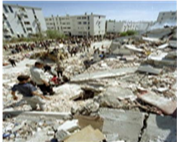
Figure I.11. Exemple de dommages [6].
