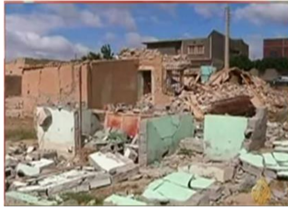
Figure I.13. Exemple de dommages [7].
