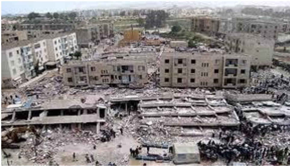
Figure 1.2. Dégâts de séisme de Boumerdès, mai 2003.
