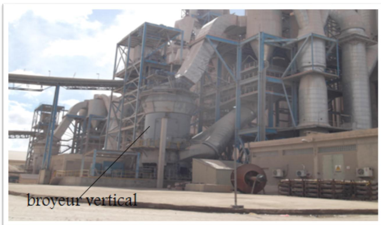
Figure I-6 : Broyage cru (vertical).
