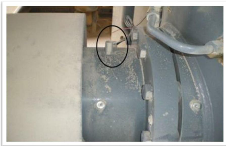
Figure II-14 : Position du capteur vibrations.
