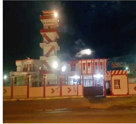
الصورة رقم (10): وحدة الحماية
