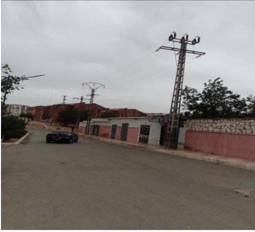
صورة رقم (15): خط كهرباء عالي الشدة
