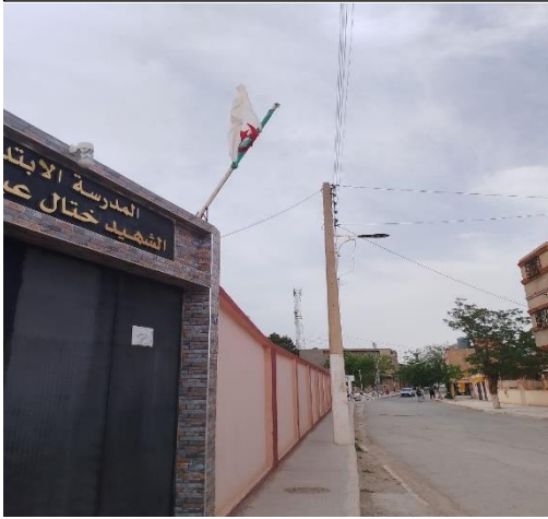
الصورة رقم (39): أعمدة الانارة
