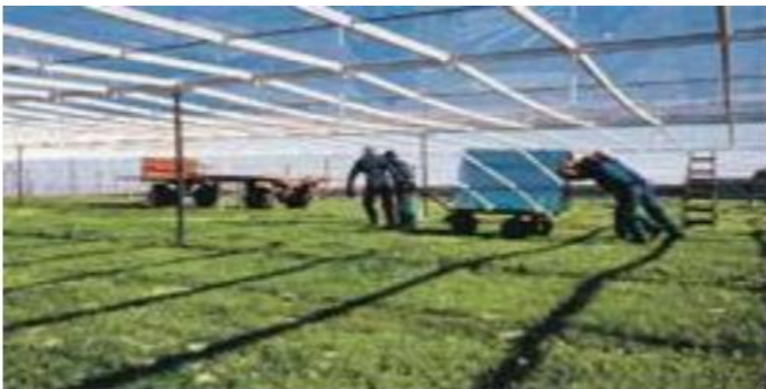
Fig. I.3 Verrière du collecteur d'une cheminée solaire
