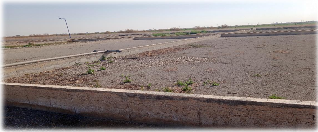
Figure III.13 : Les lits de séchage.
