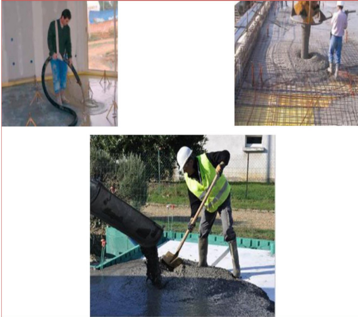
Figure. I. 23 Mise en place aisée du BAP par un seul ouvrier. [31]
