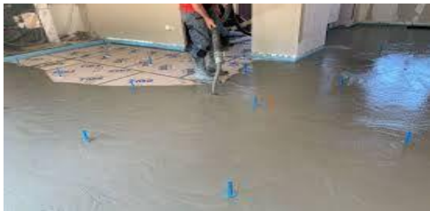
Figure I.11. Application d'une chape de sol
