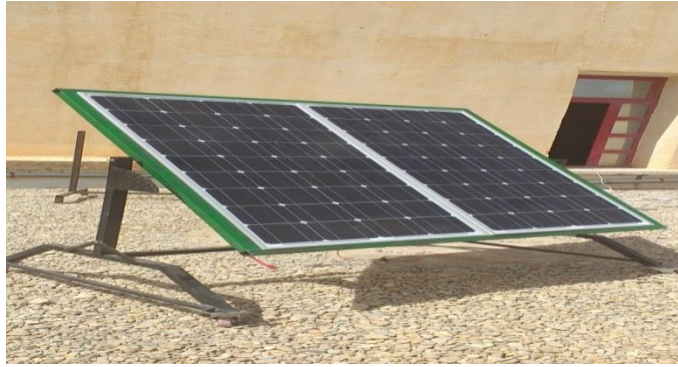
Figure.3.13-: Mesure électrique de l'arbre et des panneaux fixés
