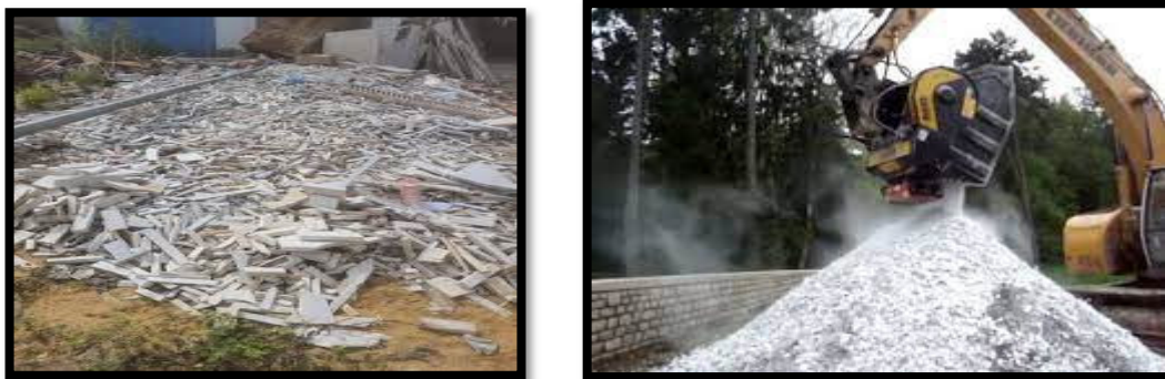
Figure II.3. Déchet de marbre.
