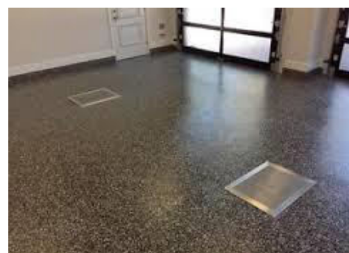
Fig.II.6 : Plancher en béton polymère.
