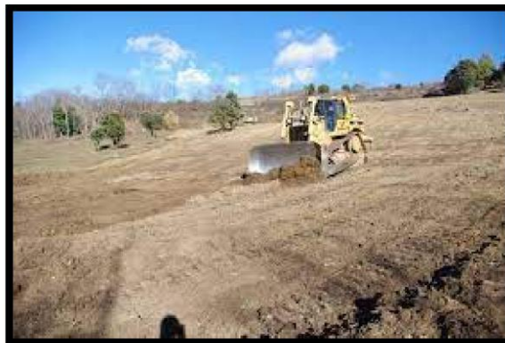
Figure I.4. Décapage de la terre végétale.
