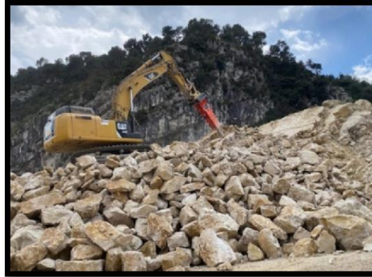
Figure I.5. Extraction des roches dures.
