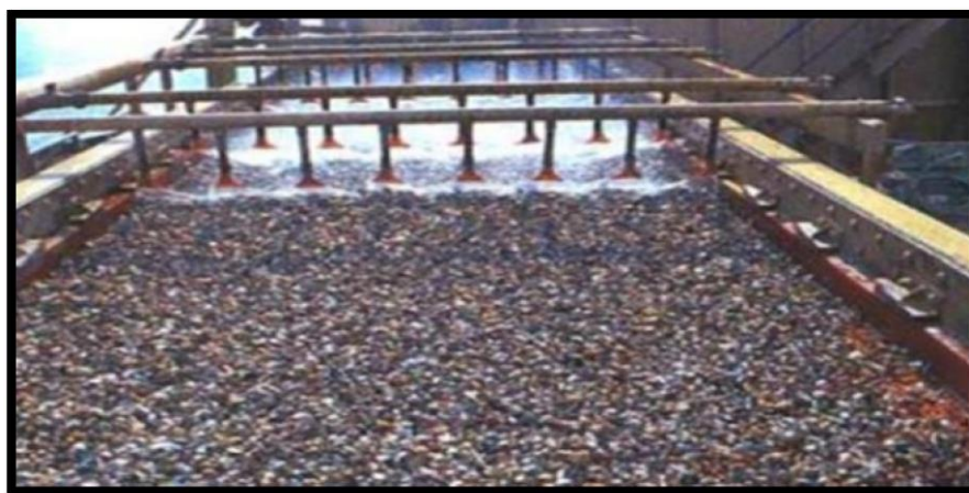
Figure I.9. Lavage des granulats.
