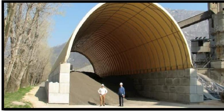
Figure I.10. Abri de stockage des granulats.
