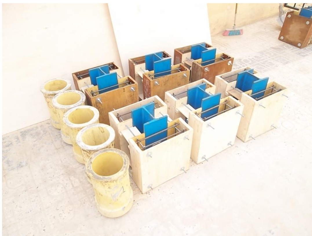
Figure II. 4. Coffrage du bloc de béton.
