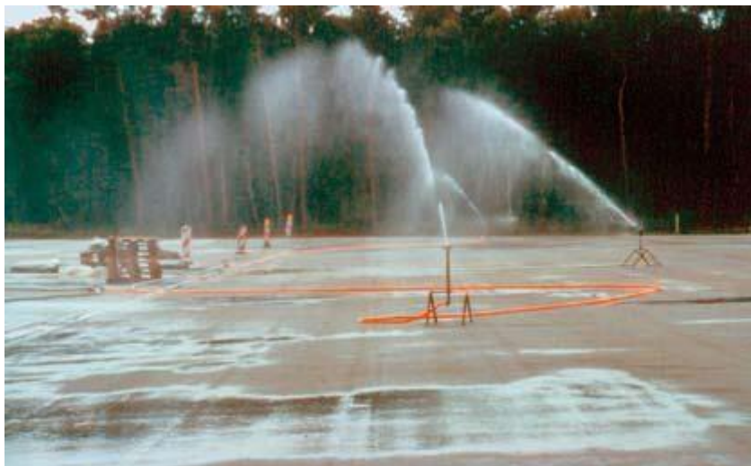
Figure.I.2.Cure du béton par arrosages ciblés [10].
