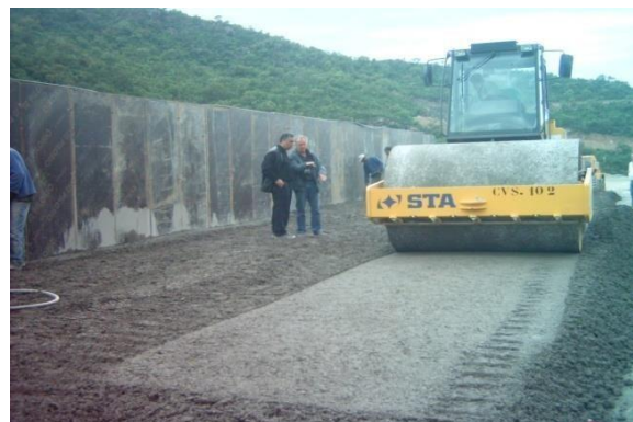
Figure.I.5.Compactage du BCR (Barrage en BCR Errmil - Tunisie) [12].
