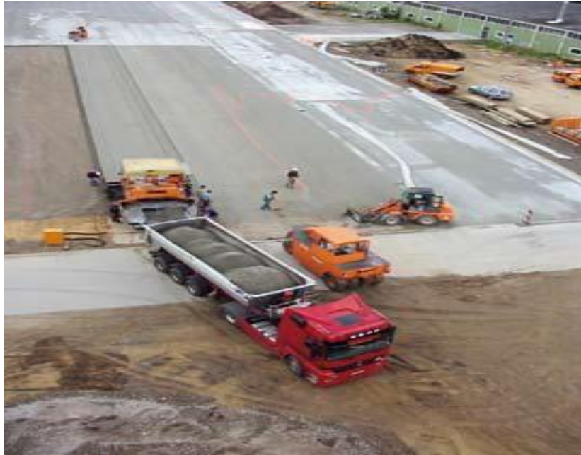
Figure.I.1.Mise en place de BCR par bandes [9].
