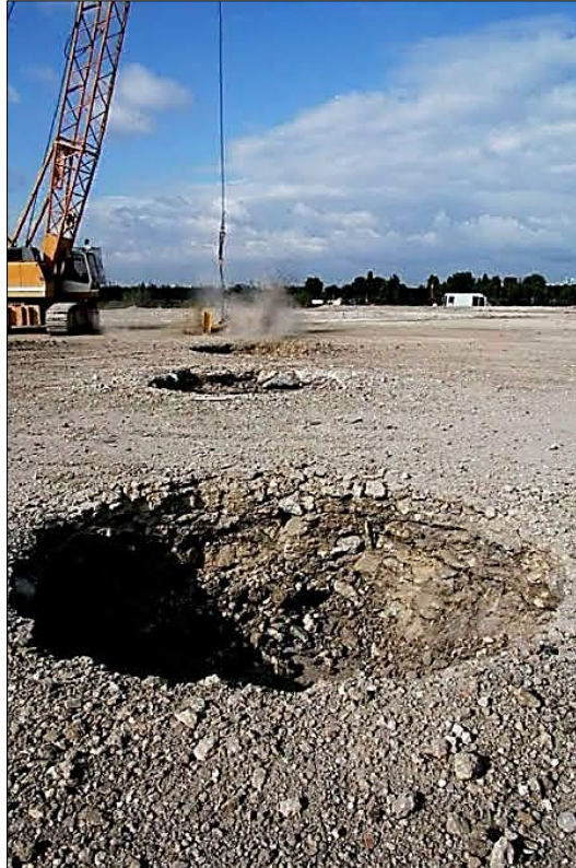
Figure I.19 : Chantier de pilonnage.
