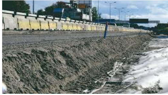
Figure I.32 : chantier de traitement du sol au ciment
