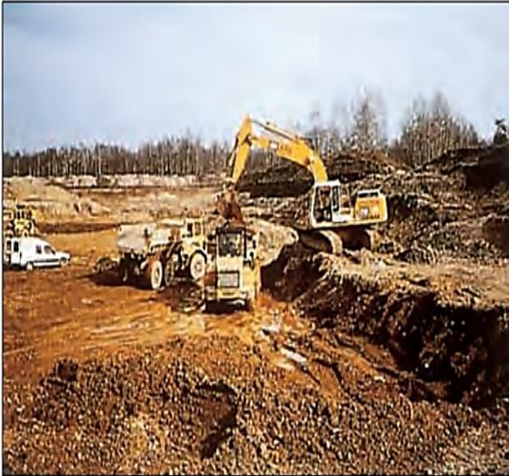
Figure I. 6 : Extraction après rabattement de la nappe.
