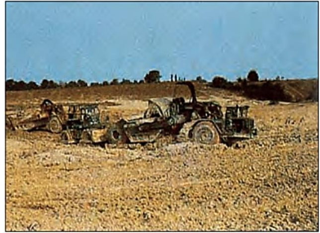
Figure I.10 : Craie de la classe R13h (craie de densité faible à teneur en eau élevée).
