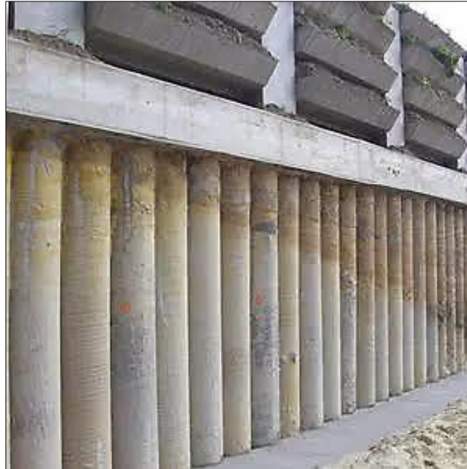
Figure I.20 : Colonnes Pilonnées.
