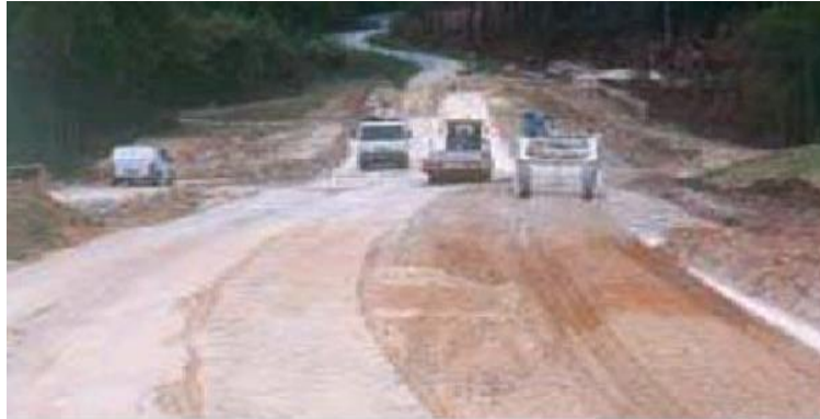
Figure I.30 : compactage final (documentation technique routes N89 septembre 2004)
