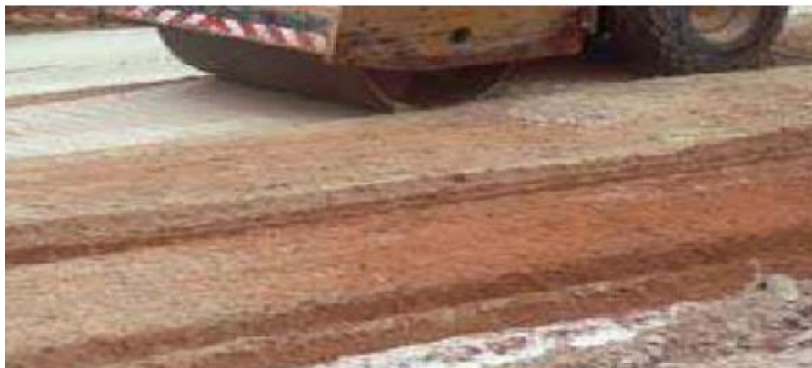
Figure I.29 : compactage partiel (documentation technique routes N89 septembre 2004)
