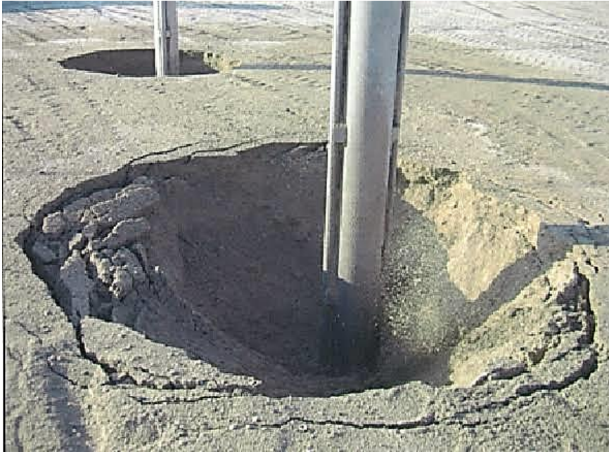
Figure I.18 : Chantier de vibrocompactage.
