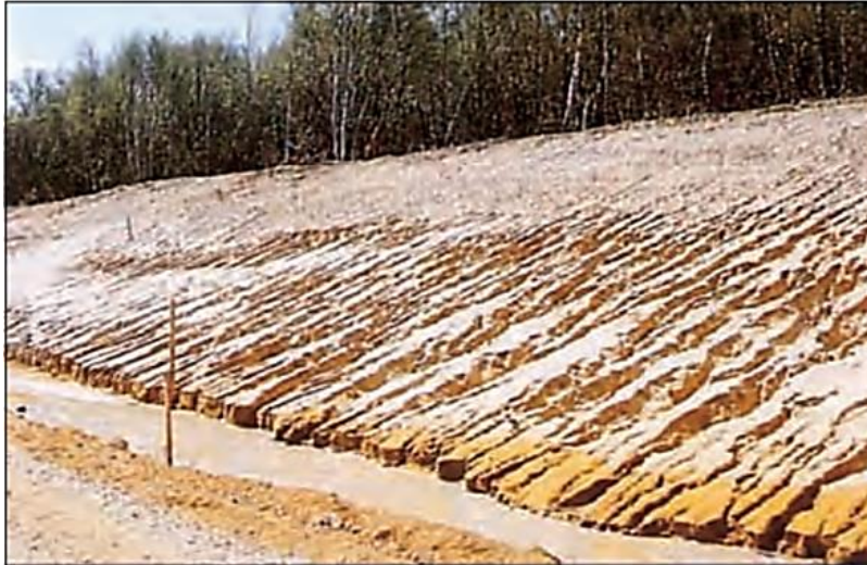
Figure I.5 : La portance des sables fins des classes B1 ou D1 est quasi-indépendante de leur teneur en eau mais ces sols sont en revanche très sensibles à l'érosion pluviale
