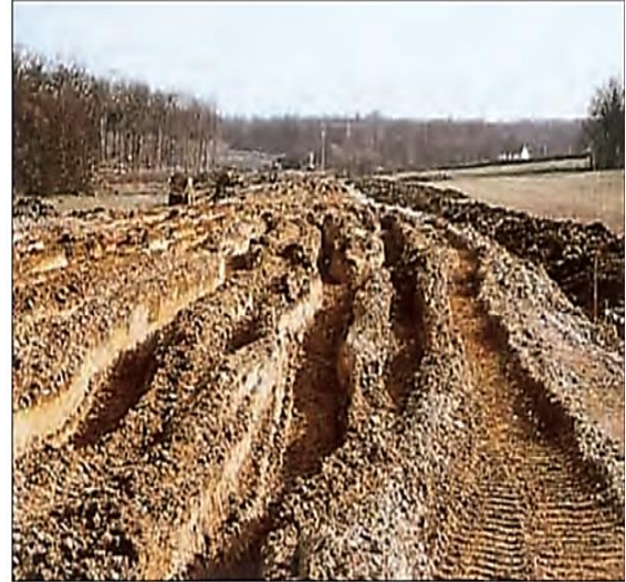
Figure I.7 : Comportement à la mise en remblai.
