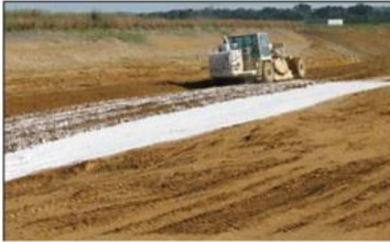
Figure IV.6 : Traitement à la chaux.
