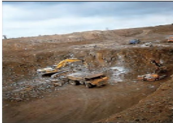
Figure I.8 : Pour déterminer un déblai rocheux, il faut au préalable être en mesure de prévoir à partir de la roche en place le comportement du matériau après abattage.
