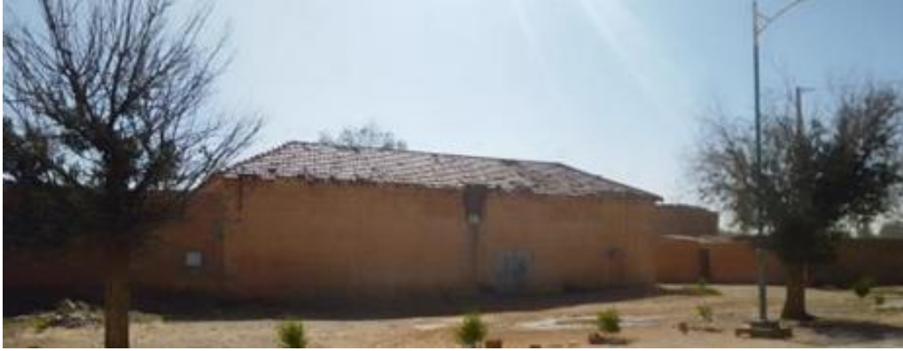
الصورة 05: مبنى ينتمي المرحلة الاولى
