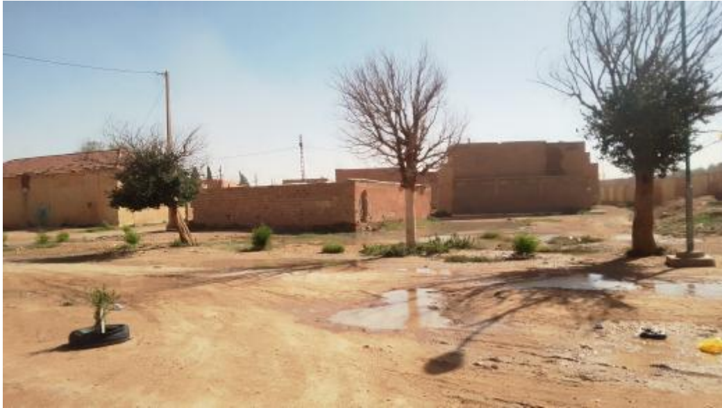
الصورة 06: مبنى ينتمي المرحلة الاولى
