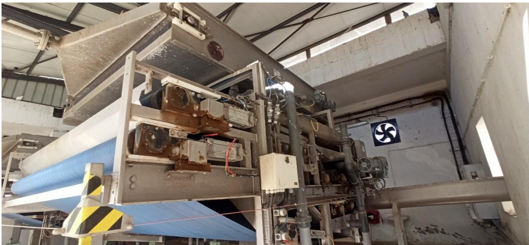
Figure II-11 Déshydratation mécanique de la STEP de Sidi Aissa.
