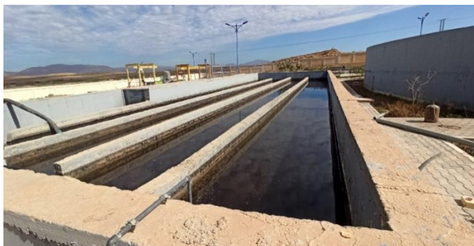
Figure II-9 Canal de chloration (chicanes) de la STEP de Sidi Aissa
