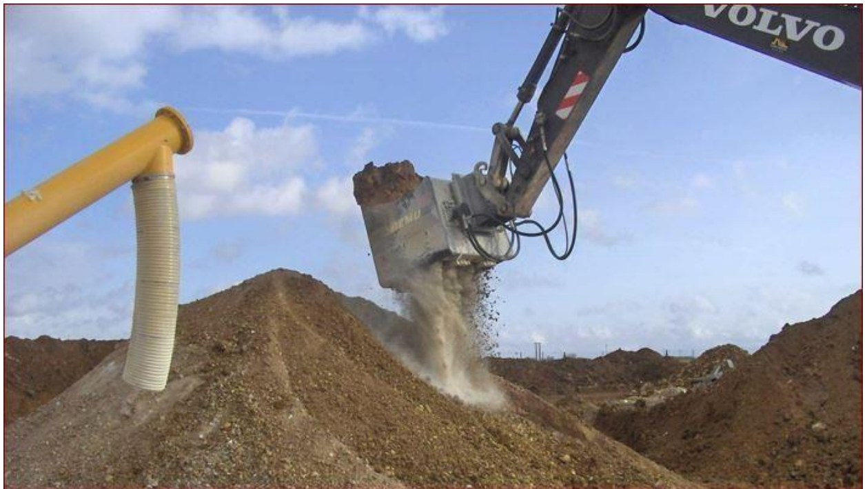
Figure I.12 : malaxage de sol avec le ciment et mise en œuvre de sol ciment
