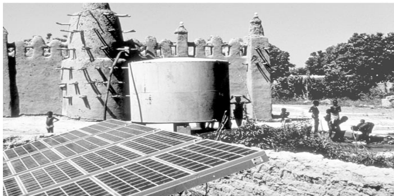
Figure I.2: Exemple de système de pompage au Mali [2]
