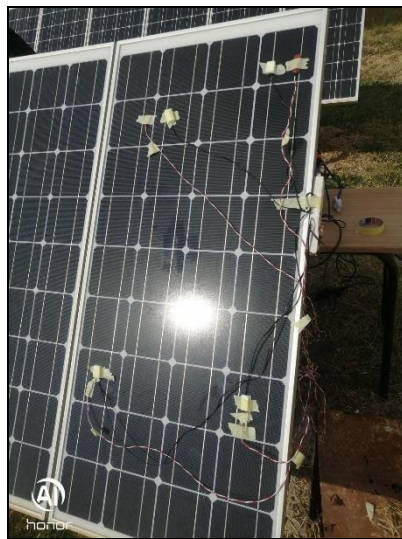
Figure II.15 : L'installation des capteurs sur le panneau.
