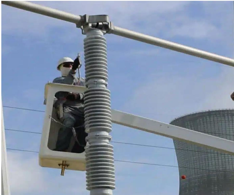
Figure 2. 8. Entretien des isolateurs sous pollution
