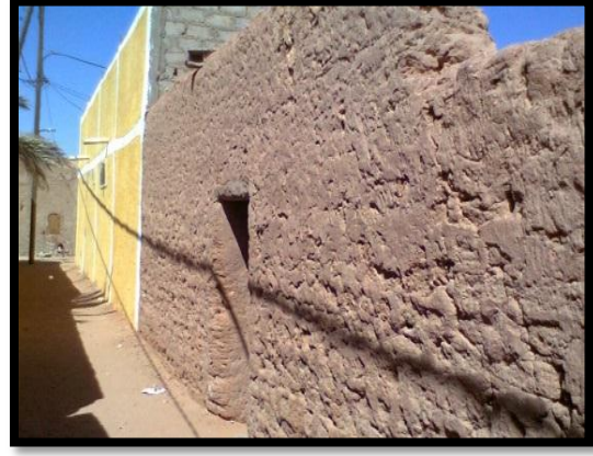
الصورة رقم (77): مسكن قبل الترميم
