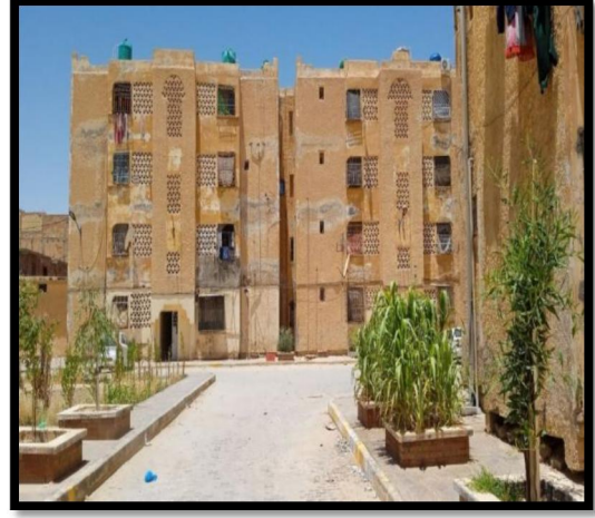
الصورة رقم (01) : مبنى ذات ثلاث طوابق
