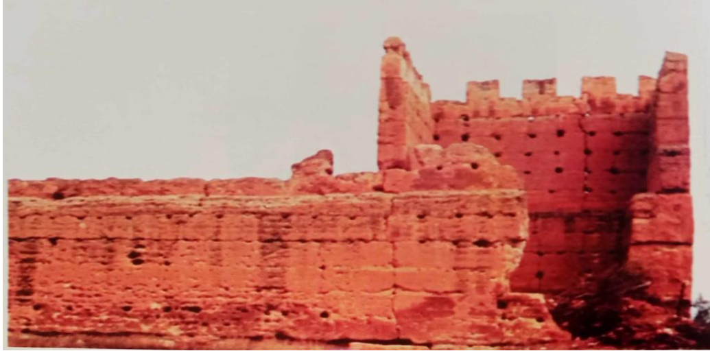
اللوحة 3: المنصورة تلمسان السور الجنوبي 1
