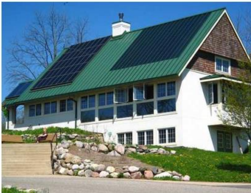
Figure III.4 Les panneaux solaires intégrés au toit
